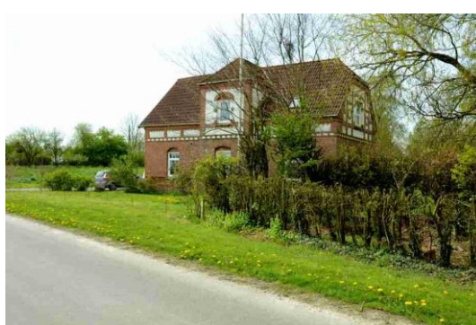
Stationen på Knagsledvej i Ustrup
