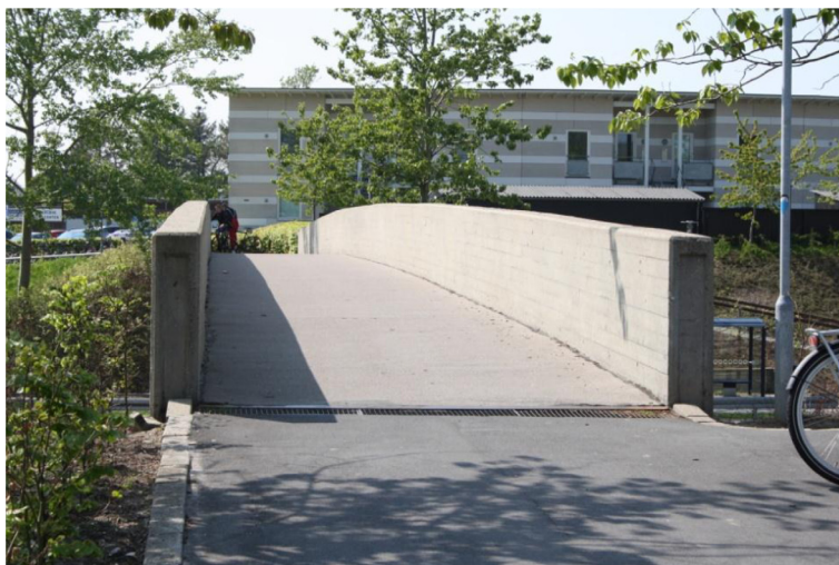
Figur 4.22: Fællessti på 3,0 m med mure. Broen har tilstrækkelig bredde, men kan virke smal når flere trafikanter mødes.
