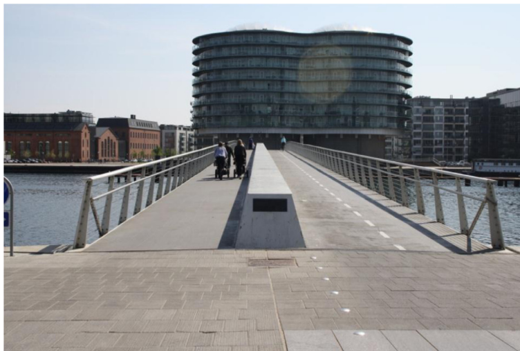
Figur 4.27: Adskilte stier – 3,0 m gangsti og 4,0 m cykelsti. De to stier er opdelt af en midterkonsol, der fysisk adskiller fodgængere og cyklister.
