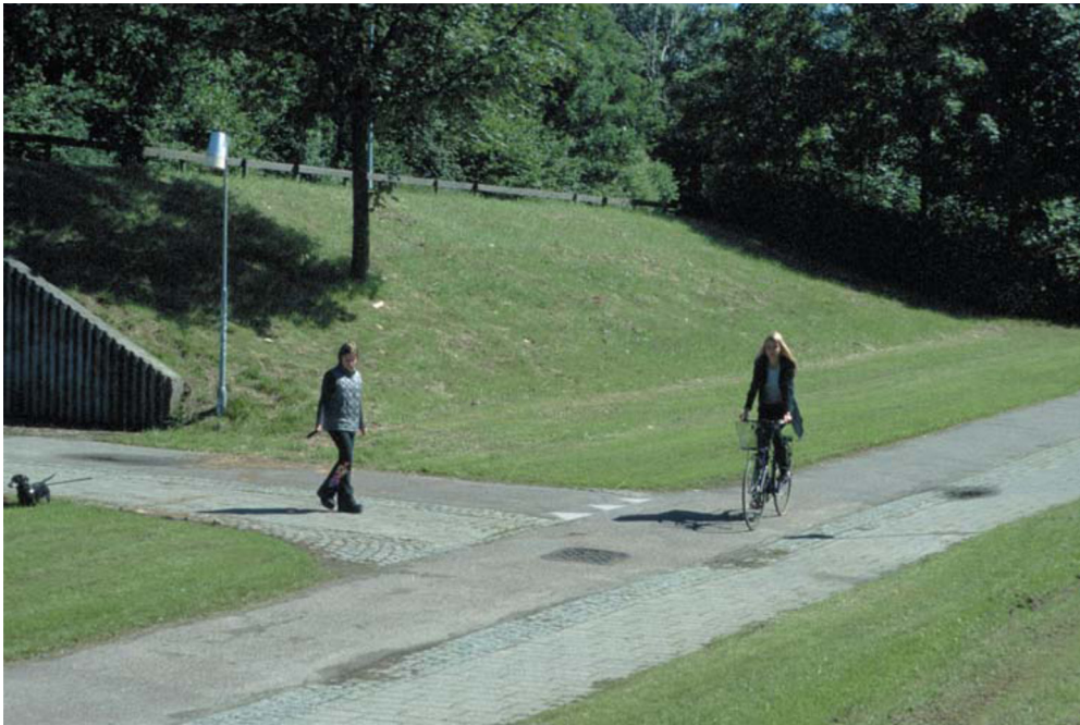
Figur 7.3: Kryds mellem to stier med cykeltrafikken adskilt fra gangtrafikken
