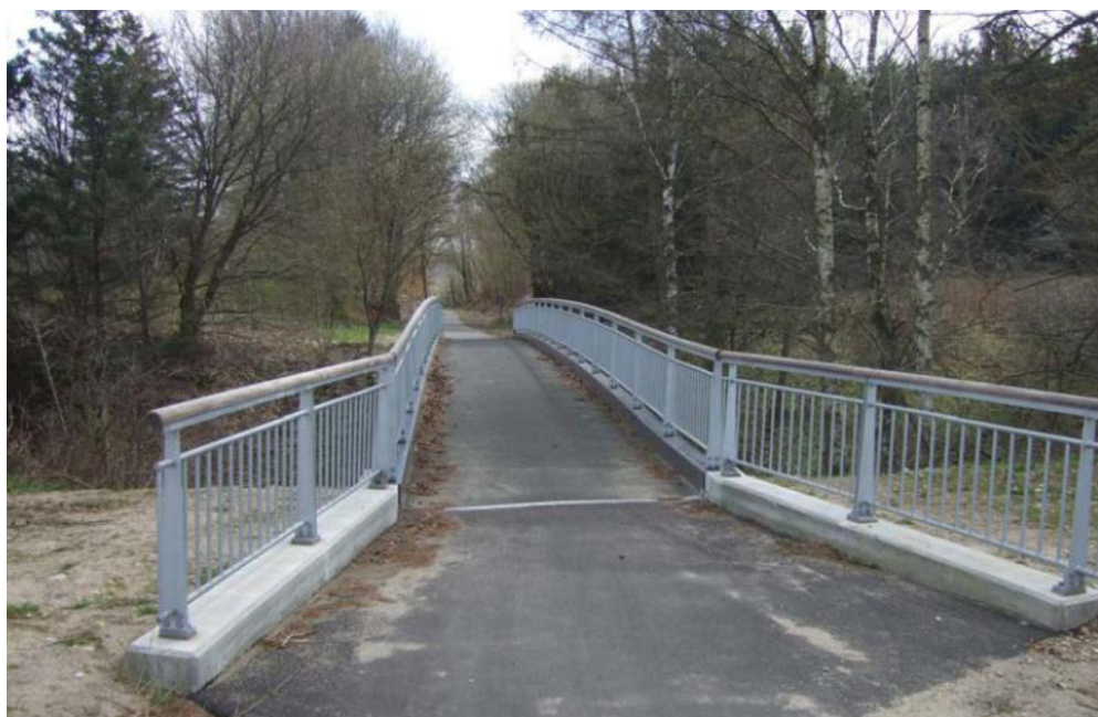
Figur 4.29: Tragtformet rækværk i overgangen mellem rampe og bro
