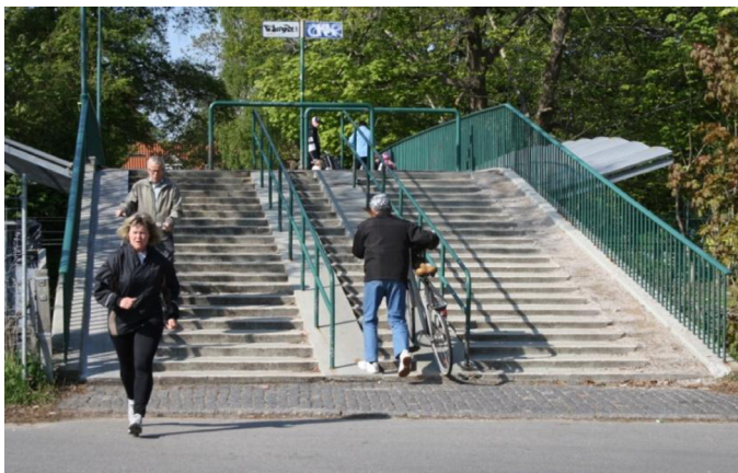
Figur 4.1: Bro med dårlig tilgængelighed pga. smalle og stejle ramper/trapper.
