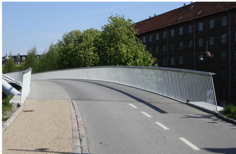
Figur 4.31: Let rækværk. Håndliste er placeret for højt.
