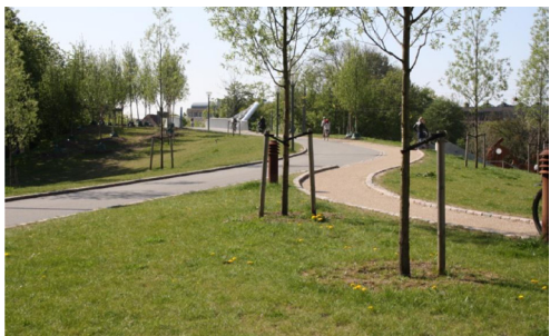
Figur 4.12: Gang- og cykelsti mødes og samles til en delt sti inden broen, så der skabes et overgangsstykke med samme indretning som broen.
