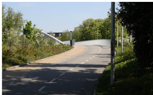
Figur 4.13: Sti og bro i sammenhængende kurveforløb giver en god overgang.
