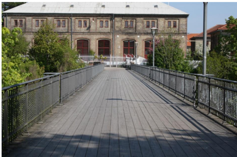
Figur 4.33: Træbro med dårlig friktion, særligt i vådt føre.
