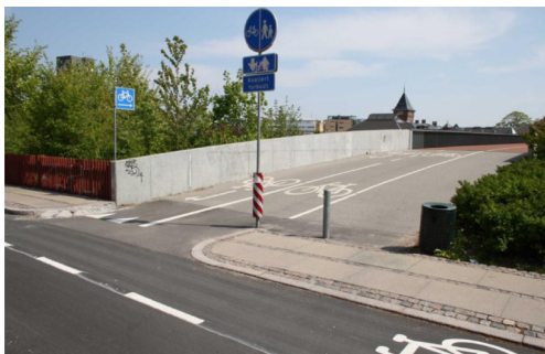
Figur 4.14: Meget kort afslutningsstykke mellem bro og krydsende cykelsti.
