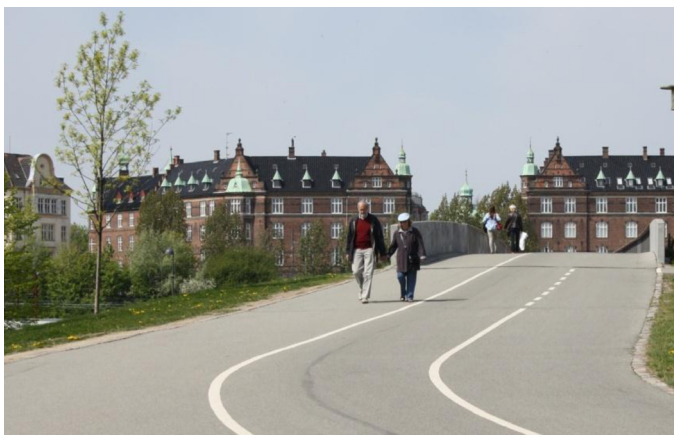
Figur 4.2: Bro med god tilgængelighed uden store gradienter. Af hensyn til synshandicappede bør adskillelsen mellem gående og kørende trafik udføres i en farvekontrast og i taktile belægning.
