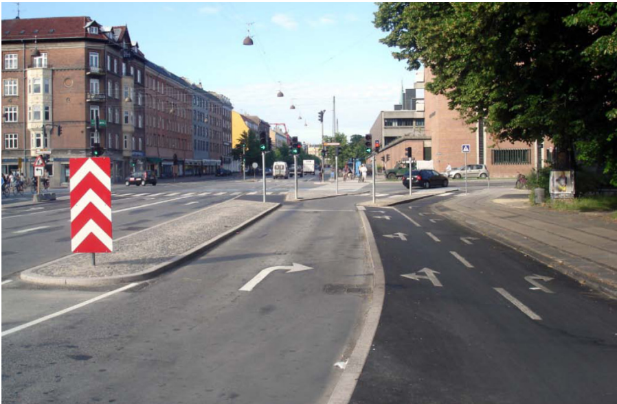
Figur 5.8: Separat regulering af ligeudkørende og højresvingene cyklister via cykelshunt.
