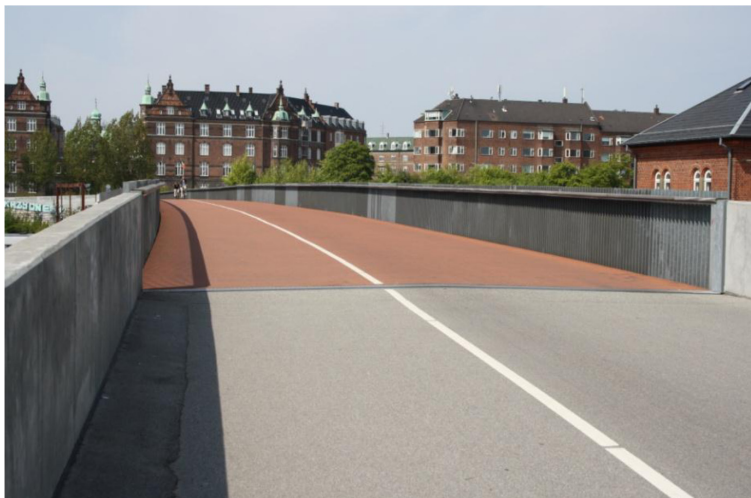
Figur 4.32: Overgang fra asfalt til kunstbelægning med lignende overflade og god friktion.
