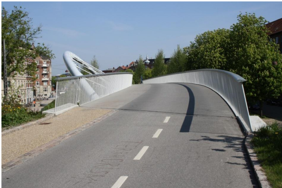
Figur 4.36: Afmærkning bør føres videre over broen.
