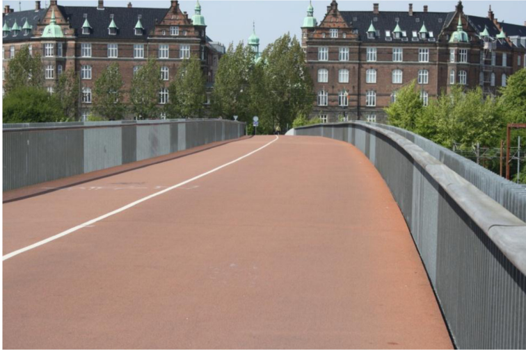
Figur 4.25: Delt sti på 3,0 m gangsti og 4,0 m cykelsti. Opdeling med afstriking, der muliggør en fleksibel udnyttelse af det samlede areal. Af hensyn til tilgængeligheden for synshandicappede bør adskillelsen mellem gående og kørende trafik også have en taktil overflade.
