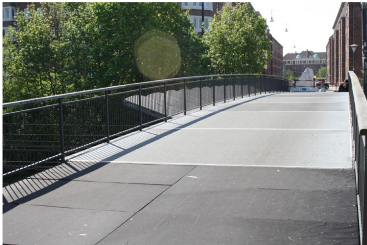
Figur 4.23: Fællessti på 5,0 m med lette rækværker. God bredde til at give tryghed for både fodgængere og cyklister.
