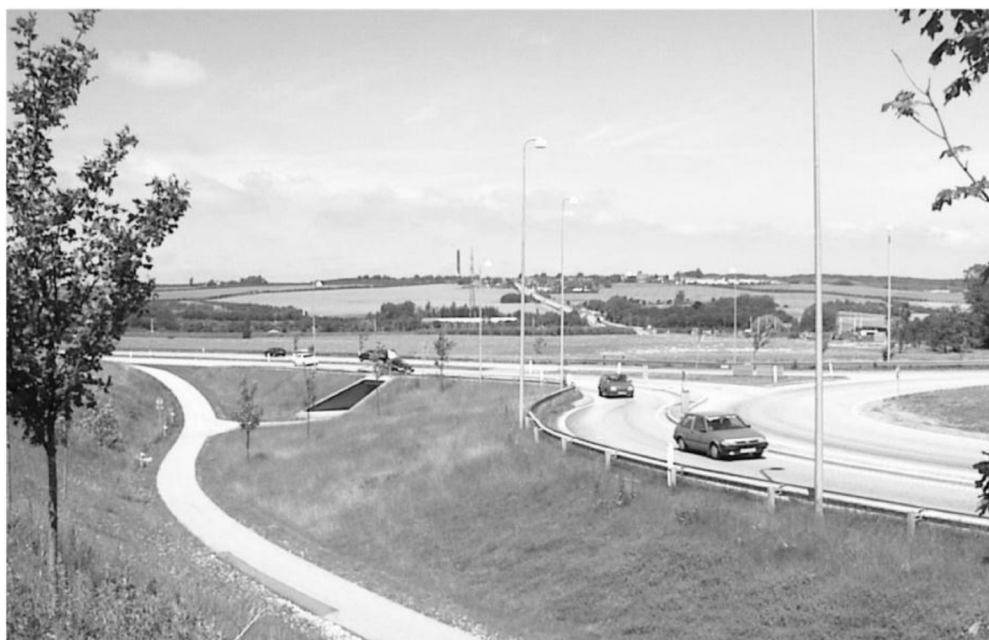
Figur 14.18: Eksempel på krydsning i to planer mellem cykelsti og vej i en rundkørsel.
