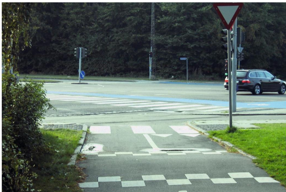
Figur 18.4: Eksempel på afslutning af cykelsti, hvor cyklisterne er pålagt vigepligten. Cyklisterne er reguleret med vigepligtstavle og bump.
