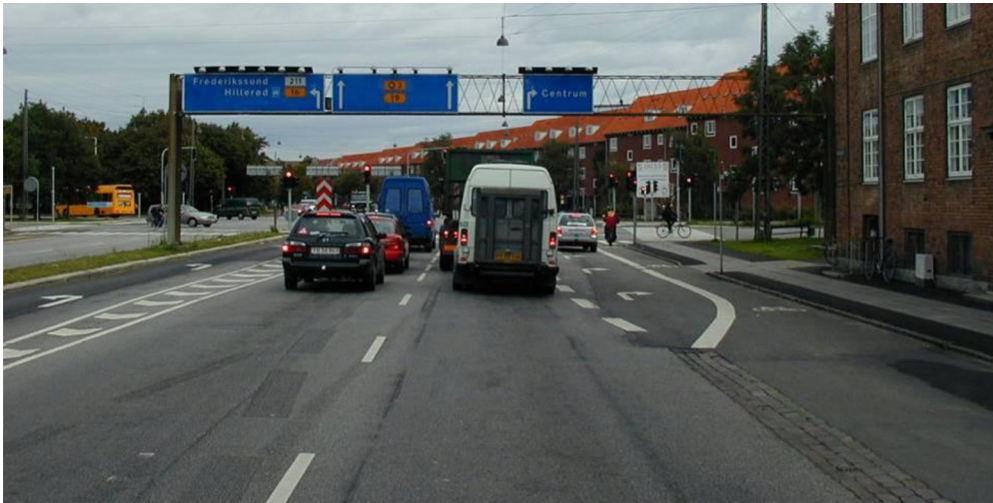
Figur 18.9: Eksempel på afslutning af en cykelsti i en kort cykelbane før krydset.
