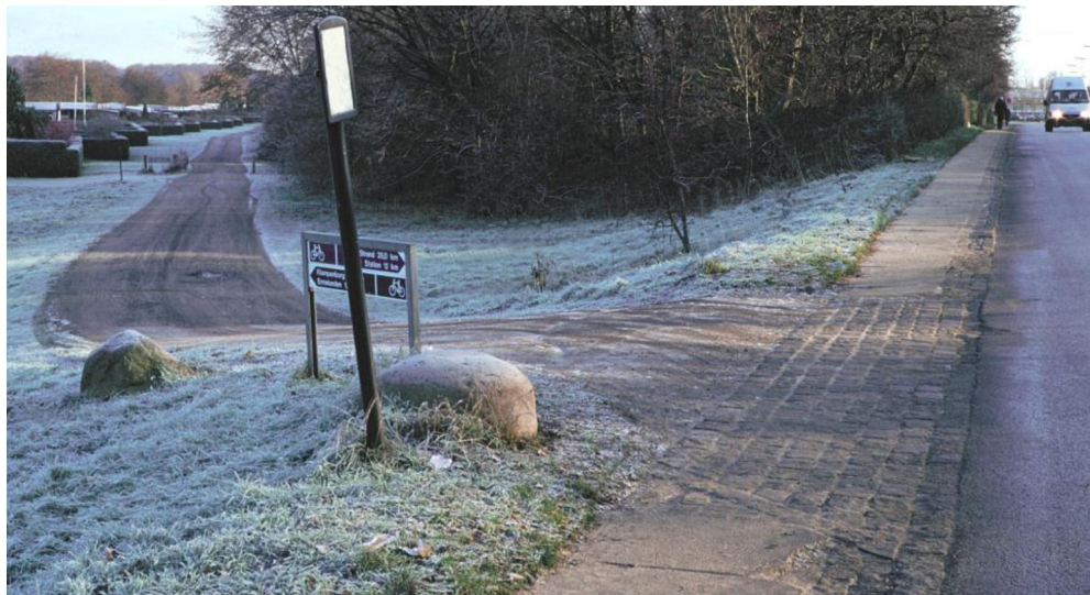
Figur 8.10 Stigning anvendt som fartdæmper
