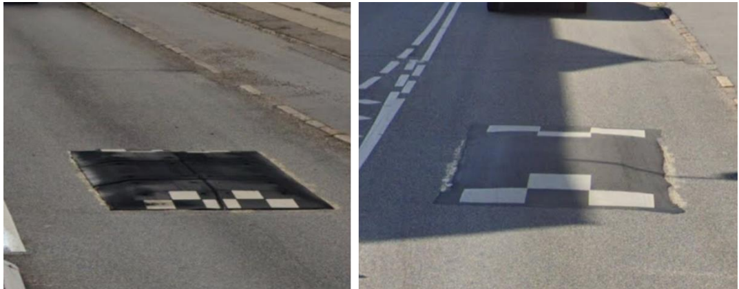
Figur 2: Tv.: Tidligere plastikpudebump på Helligkorsvejs vestlige vejgren. Th.: Nuværende asfaltpudebump på Helligkorsvejs vestlige vejgren.
